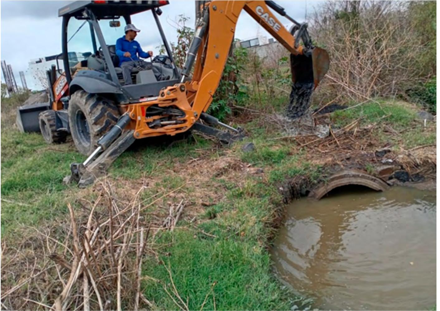
**Realizamos el mantenimiento, desazolve y rehabilitación** del colector Almoloya en San Francisco Acatepec con la finalidad de evitar obstrucciones, proteger la salud pública, prever la contaminación, prolongar la vida útil del sistema y mejorar la seguridad y calidad de vida de la población.
